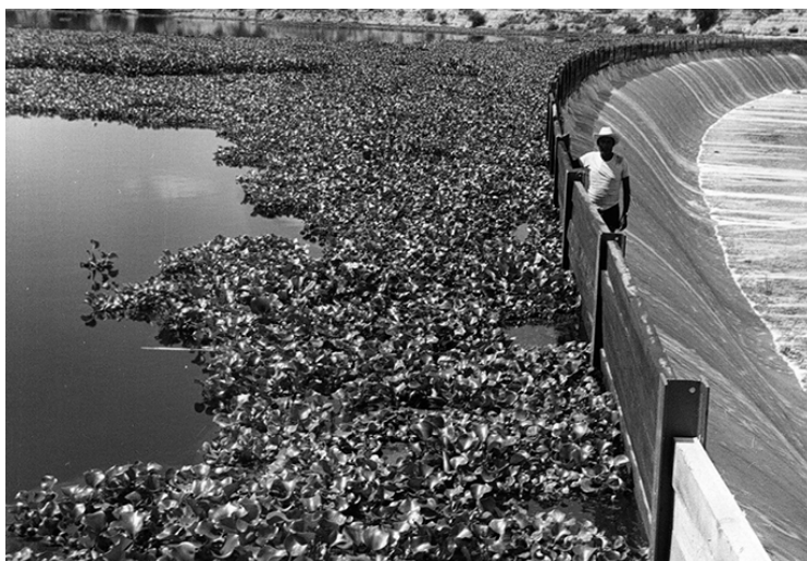
FOTOGRAFÍA 4. LIRIOS EN EL VASO DE LA PRESA ENDHÓ, 1970
