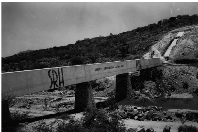
FOTOGRAFÍA 3. SIFÓN Y PUENTE PANALES EN IXMIQUILPAN, HIDALGO, OCTUBRE DE 1965
